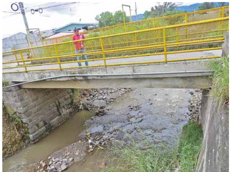
Proodus realiza mediciones a los cauces de los ríos para construir modelos de inundaciones y estudiar posibles impactos en la infraestructura del sistema vial, como esta en La Lima de Cartago, hecha por el asistente de Ingeniería Civil, José Quirós Campos (foto cortesía Proodus).
